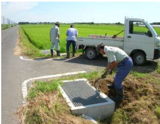
路肩の補修・草刈
